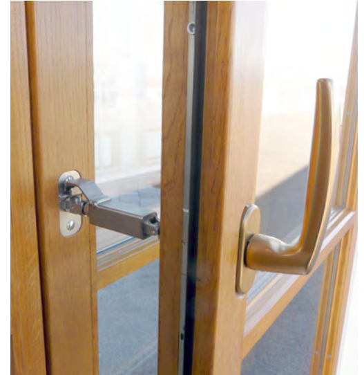
Innovatives System zur gleichzeitigen Öffnung beider Kastenfensterflügel
